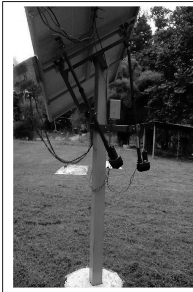
รูปที่ 4 ระบบไฟฟ้าเซลล์แสงอาทิตย์แบบติดตามดวงอาทิตย์ 2 แกน
