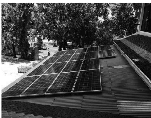
รูปที่ 3 การติดตั้งโซลาเซลล์แบบอนกริดในชุมชน
