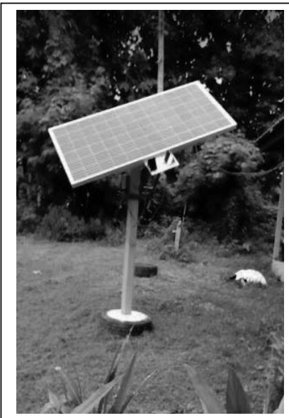
รูปที่ 4 ระบบไฟฟ้าเซลล์แสงอาทิตย์แบบติดตามดวงอาทิตย์ 2 แกน
